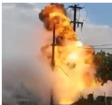
Figura nr. 154 – Incendierea unui transformator: a) supraîncălzirea, semn al apariției flăcărilor, b) producerea unui fireball 148
