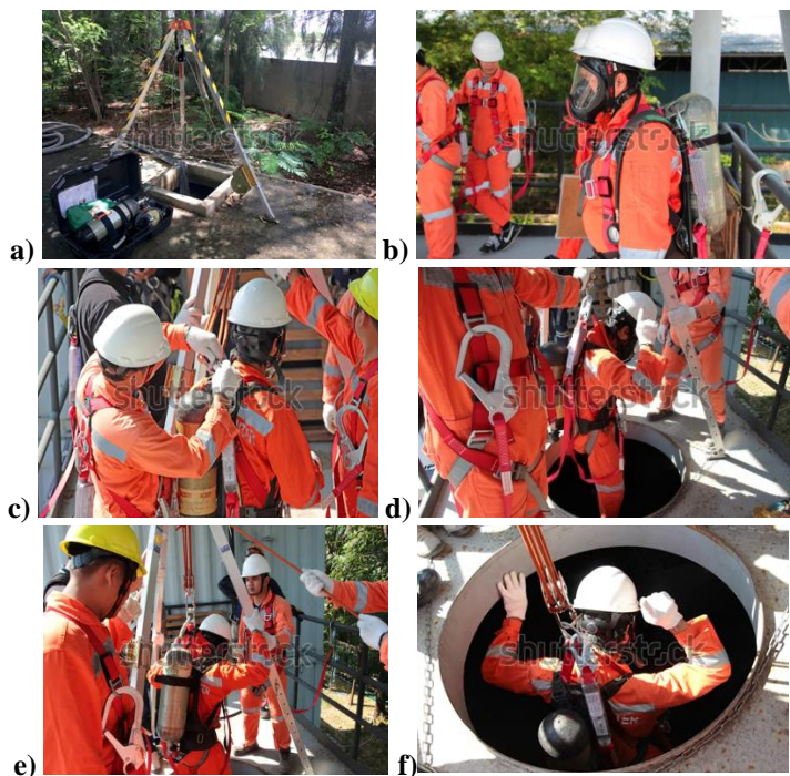
Figura nr. 120 – Detalierea etapelor salvării din puț folosind trepiedul 117 a) pregătirea echipamentelor, b) echiparea, c) echiparea hamului, d) verificarea intrării în puț, e) intrarea în puț, f) formarea unei imagini reale asupra modului de salvare a victimei
