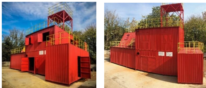
Figura nr. 1 – Vedere de ansamblu a poligonului de căutare-salvare
