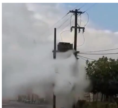
Figura nr. 154 – Incendierea unui transformator: a) supraîncălzirea, semn al apariției flăcărilor, b) producerea unui fireball 148
